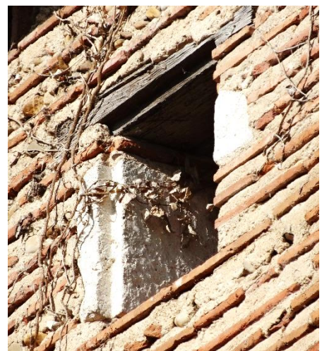
Maçonnerie de tuileaux et galets, pierres de taille en calcaire blanc et linteau feuilluré en chêne
